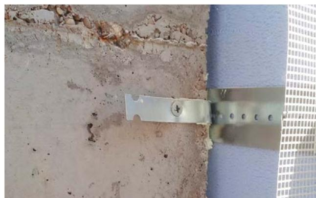
4. Fissaggio esterno con turbovite
