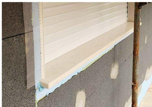
12. Paraspigoli in PVC con rete anti-fessurazione
