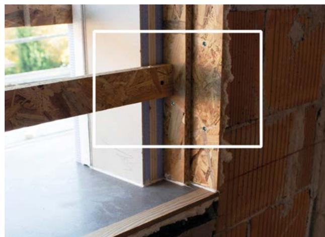
3. Fissaggio interno con turbovite
